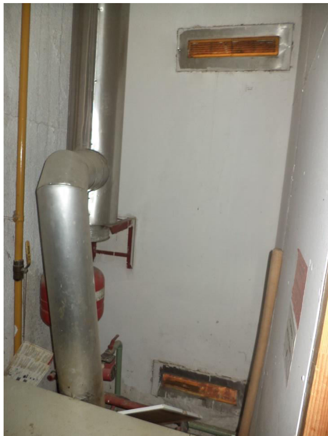
Postojeći dimovod i dimnjak plinskog kotla
