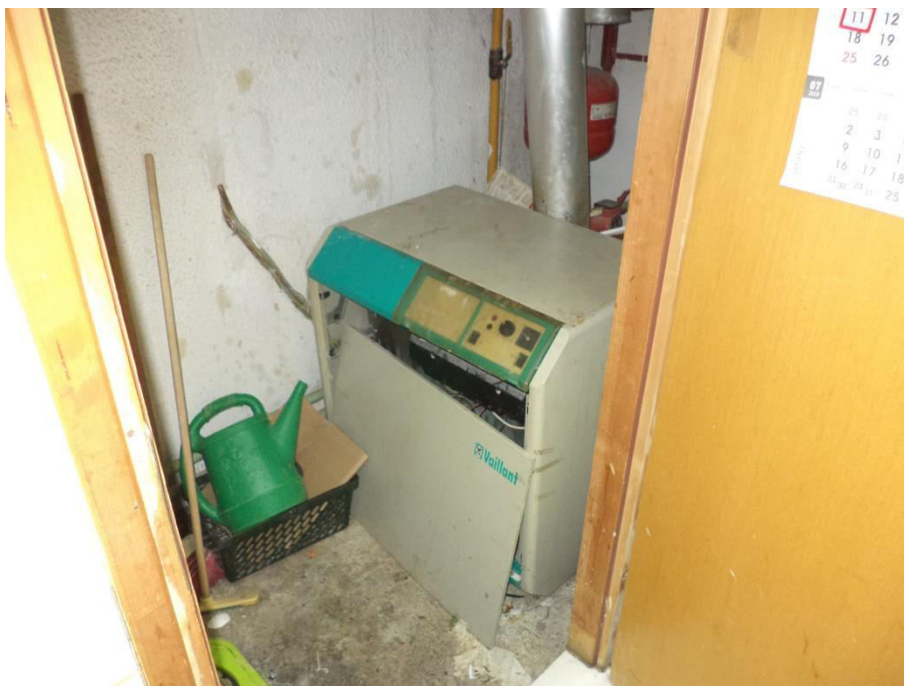
Postojeći plinski kotao Q=47,7 kW
